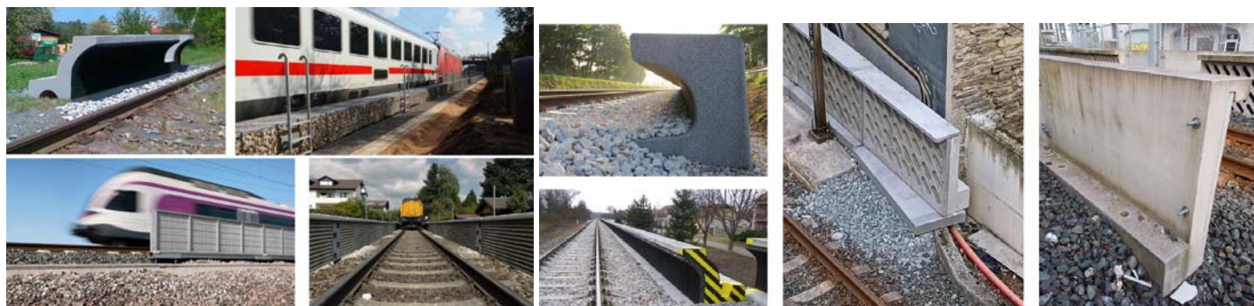
Ниске баријере против буке постављене у Шпанији које према мерењу умањују буку до 3 децибела
