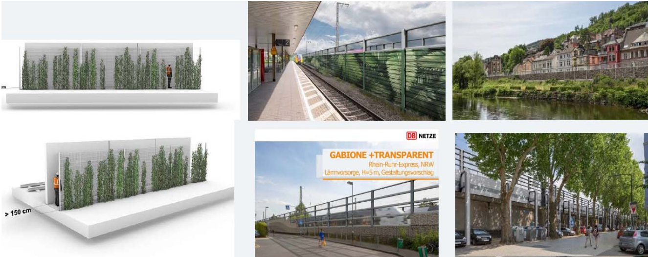
Панели против буке од различитих материјала, израђени различитим технологијама на немачкој железничкој инфраструктури
