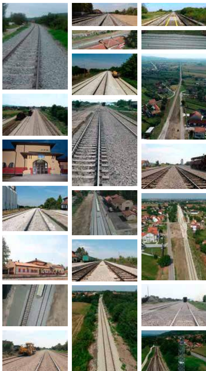
Пруга након завршене реконструкције
