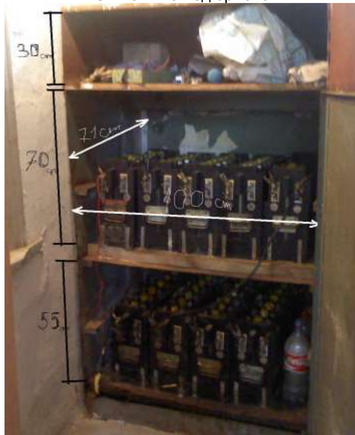
Слика 2-Унутрашње димензије ормана
