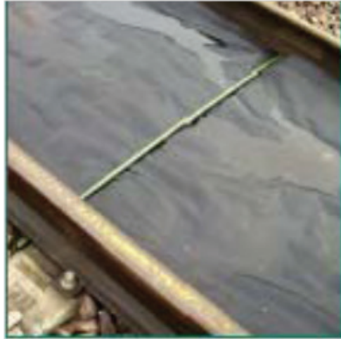
Слика 9. Пример заштитног подметача за апсорпцију евентуално просутог уља причвршћеног за шине
