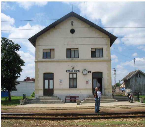
Слика 1 Станична зграда Кисач - поглед од стране колосека
