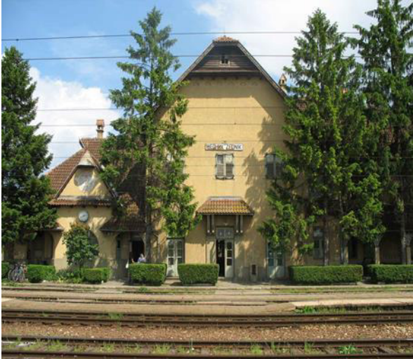
Слика 34 Станична зграда Жедник - поглед од стране колосека
