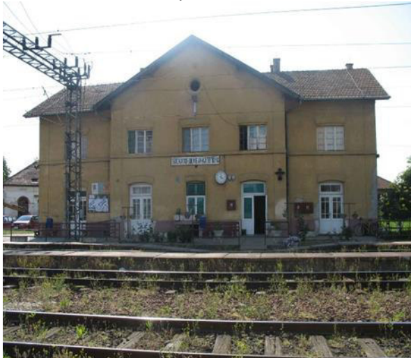
Слика 24 Станична зграда у Бачкој Топли - поглед од стране колосека
