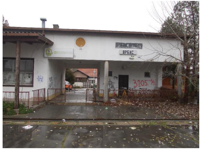
Слика 17 Станична зграда Врбас - поглед од стране приступног пута
