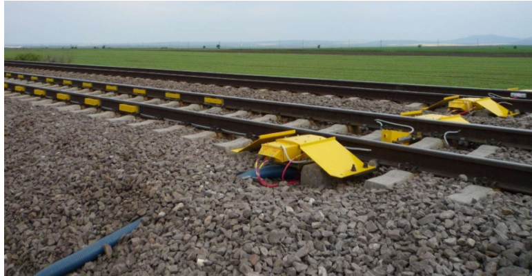
Слика 2.17 Веза каблова уређаја
