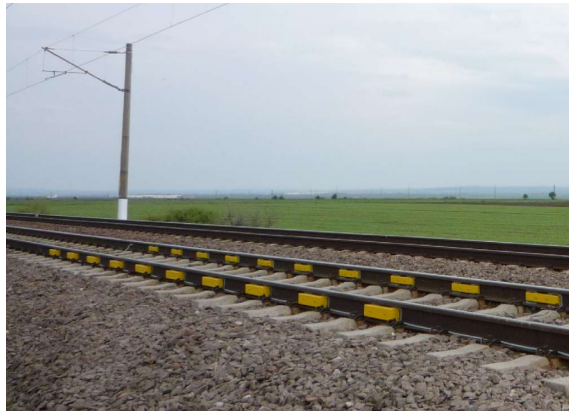
Слика 1.11 Уређај за динамичко мерење масе и равних места на точку
