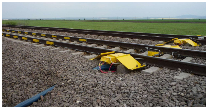
Слика 1.17 Веза каблова уређаја
