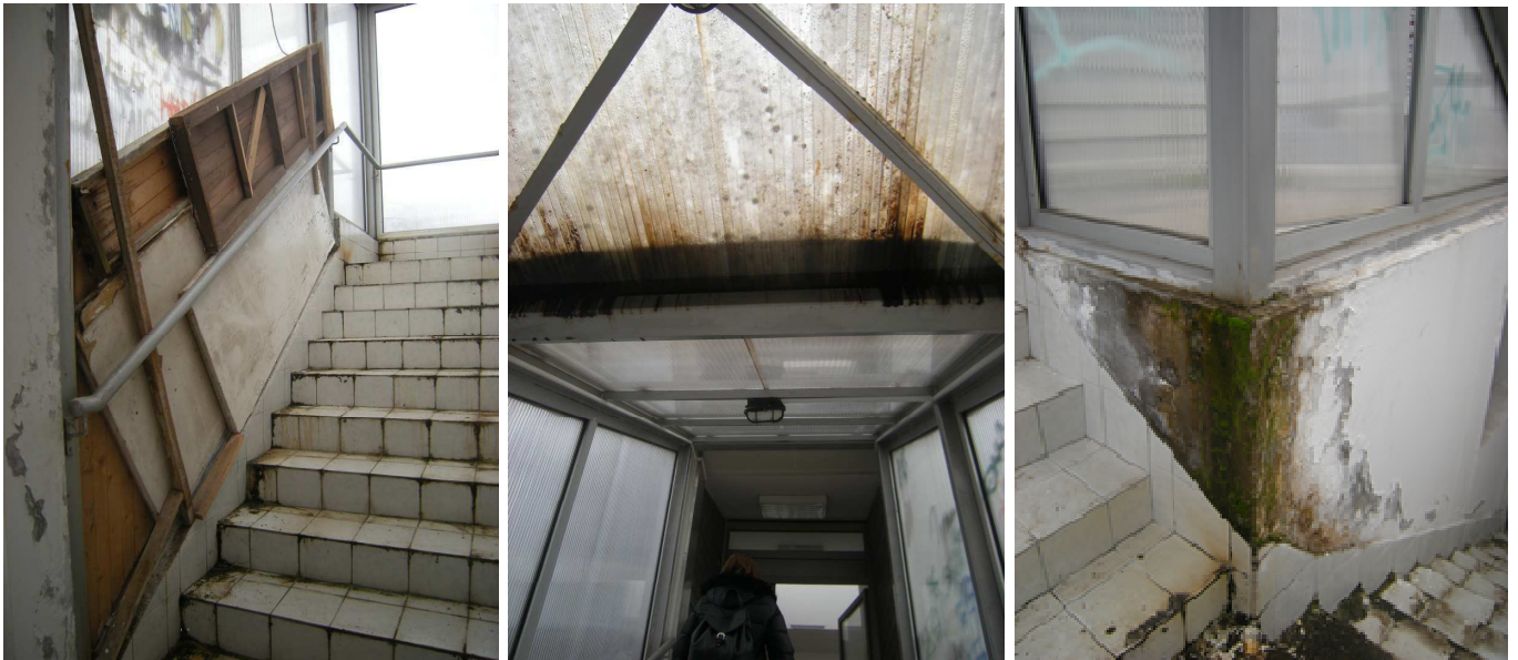
Оштећења на степеништу за спрат
