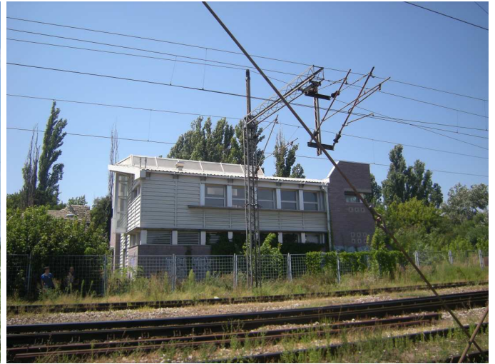
Изглед објекта са колосечног платоа
